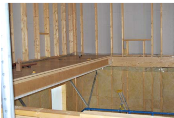
Bjälklag till elevhem, Lindesberg
